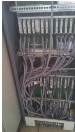
Figure 1.3.2 – Vue arrière du PBAX de Dakar
